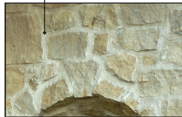
Sydney (Overgrout) shown
